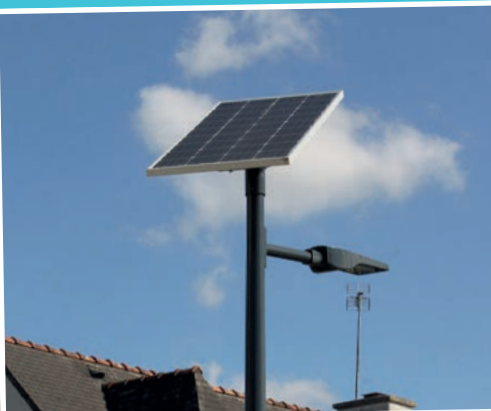
A Pluneret, dans un lotissement en impasse, la solution de mâts solaires préférée au creusement d'une tranchée pour remplacer un câble déficient, d'autant qu'aucun obstacle ne vient gêner en hauteur le rechargement des cellules photovoltaïques.
